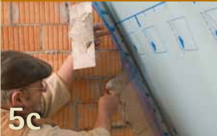
Anschluss an noch unverputzter Wand
