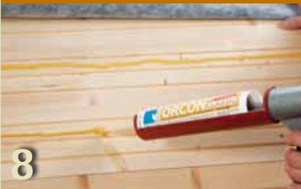
Anschluss Luftdichtung außen
