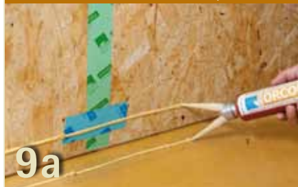
Anschluss OSB Wand/Bodenplatte
