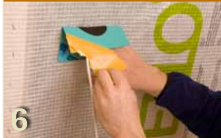
Detail Rohr- und Kabeldurchführungen
