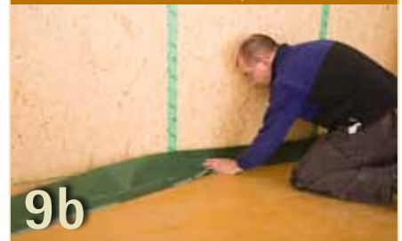
Anschluss Wand/Bodenplatte
