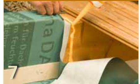
Anschluss Sub- und Top-Bahn
